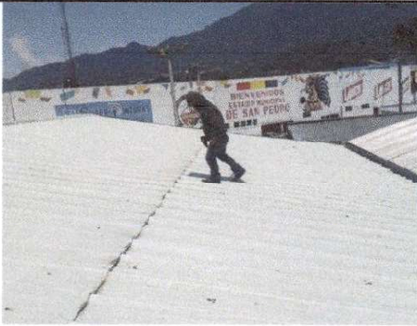
Foto1: Sustitución de lámina
