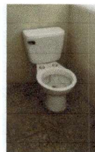
Foto 6: Reparación de accesorios de sanitarios
