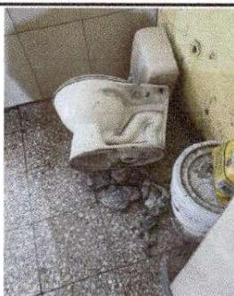
Foto 5: Reparación de sanitarios
