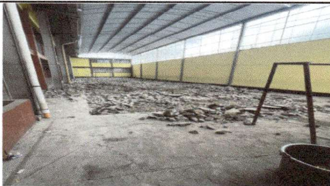
Foto 3: Demolición de piso en mal estado
